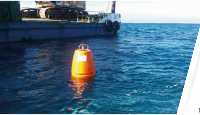
Posizionamento gavitelli di ormeggio
